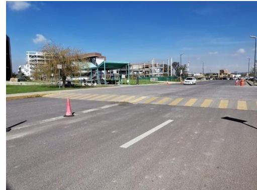
pasos de cebra (franja señalizadora), tiene como mínimo de ancho 2 metros en las orillas de los andadores. La rampa del paso peatonal se ajusta al nivel de los 17 cm que mide el peldaño de la acera convirtiéndose en una superficie lisa para el desplazamiento peatonal y de personas en muletas o en silla de ruedas.
